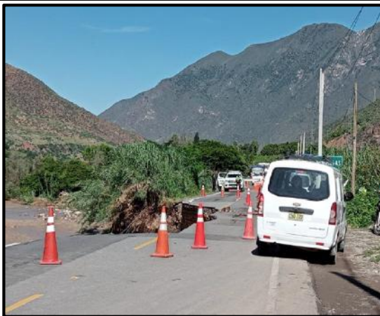
FIGURA N°02: LA RED DE ALUMBRADO Y VIA NACIONAL DE RUTA PE 08, SE ENCUTRAN EN PELIGRO POR EL INCREMENTO DE LAS LLUVIAS POR DESBORDE DEL RIO MAGDALENA
